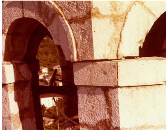
Figura 1.2.1 – Spostamento a causa di una sollecitazione orizzontale.
